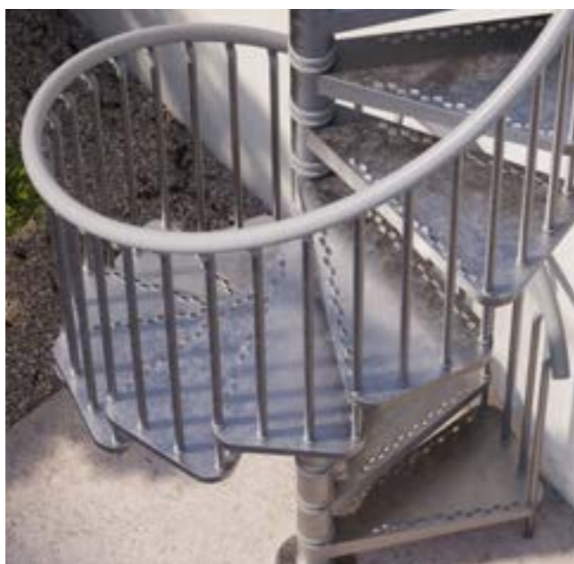
Détail de la main courante et du garde-corps modèle à colonnes verticales sur marches en acier protégé.
